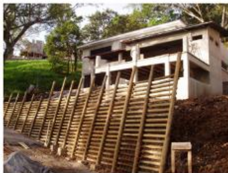
Fig. 3 Muro de retención de suelos en Urbanización Vista Real en Santa Ana, Costa Rica.
