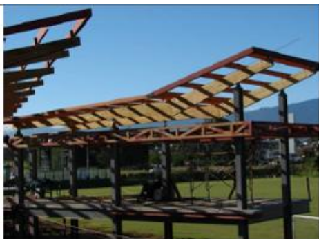
Vista parcial de la instalaciones de proyecto Goal de la Fedefutbol en San Rafael de Alajuela. Observe las vigas de madera de 14 mt. de longitud.
